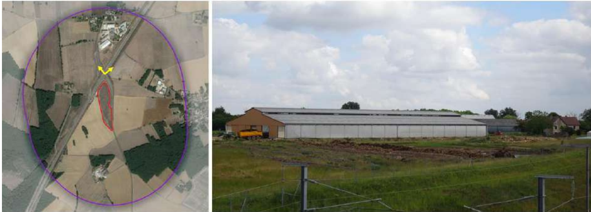
Figure 160 : Photographie de la SARL Bonneau présente dans le lieu-dit de Montmatin (Valence-en-Poitou) (Crédit photo : NCA Environnement)
