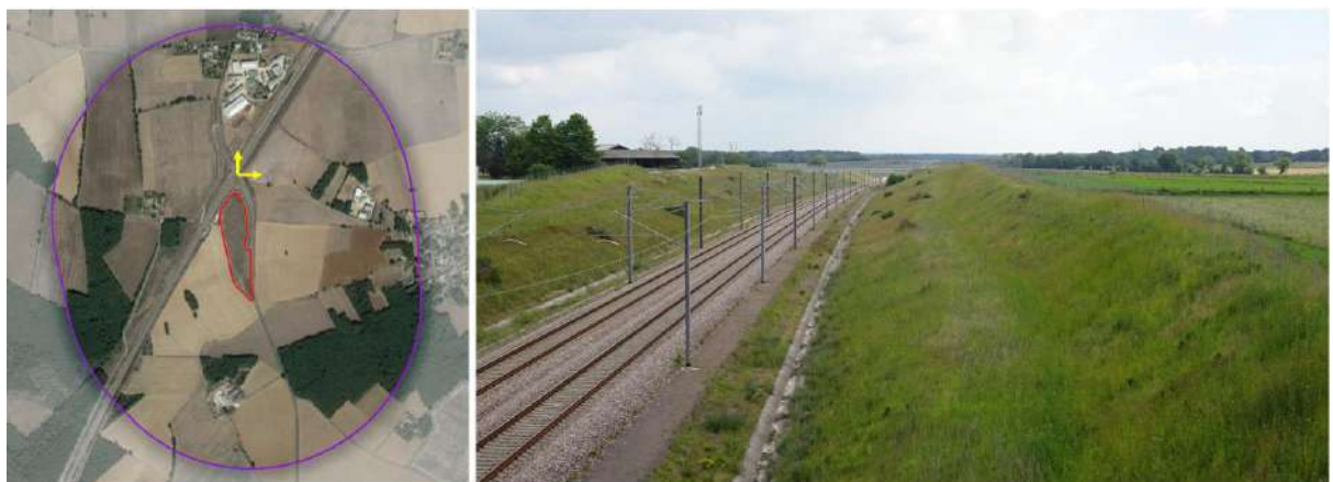
Figure 157 : Photographie des remblais contenant la LGV Sud Europe Atlantique (Crédit photo : NCA Environnement)
